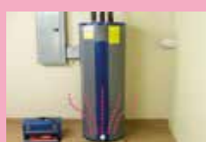
Chaufferie, buanderie, cellier etc
